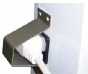
Bild 10. Skydd av karmmotståndets kontakt
