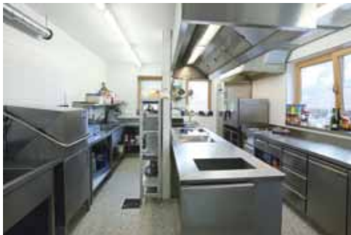
Keittiö on pieni mutta sopivan kokoinen 70-paikkaisen ravintolan pyörittämiseen. Maisemaikkunat tuovat avaruutta pieniin tiloihin.
