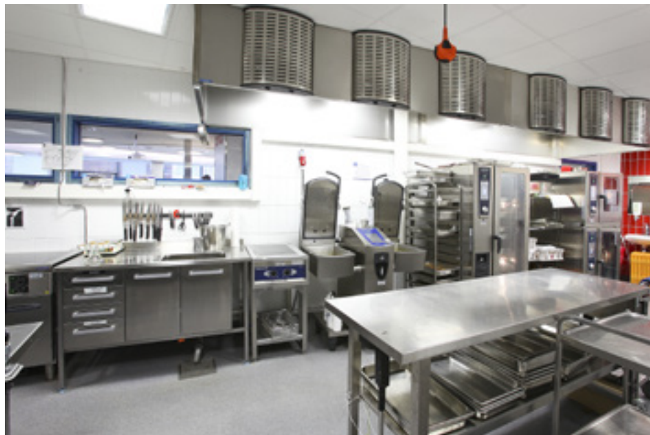
Lisätehoa keittiöön tuo Metoksen VarioCooking Center (kuvassa keskellä). Tästä lähtee 600 annosta. Ravintolasali on heti ikkunoiden takana.
