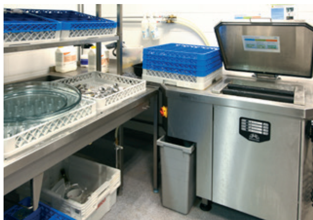
Metos Rendisk Solus Eco -jätepuristin vähentää 80 % biojätteen tilavuudesta. Automaattinen pesuohjelma puhdistaa koneen päivän päätteeksi.
