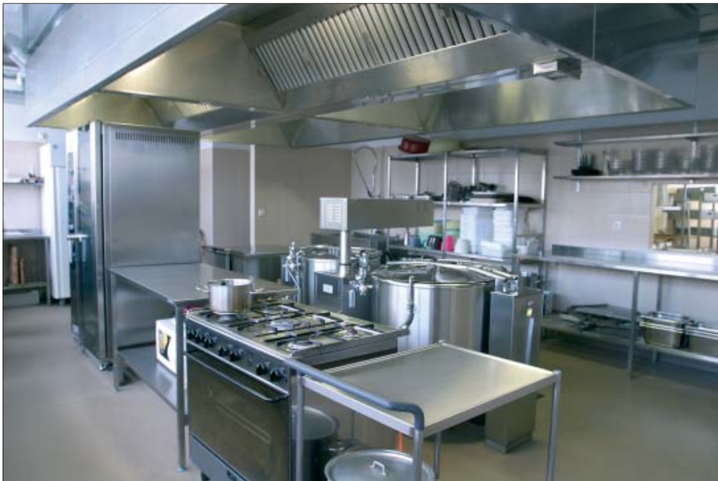
Tässä keittiössä valmistuu ruoka 800 oppilaalle. Keittiön keskilattialla on paistinpannu, sekoittava kombipata, kaasuliesi uunilla ja yhdistelmäuuni. Ympäröivillä seinillä on valmistus- ja leivontatilaa. Pesuosasto on tässä oikealla seinän takana ja taukotilat keittiön takaosassa.
