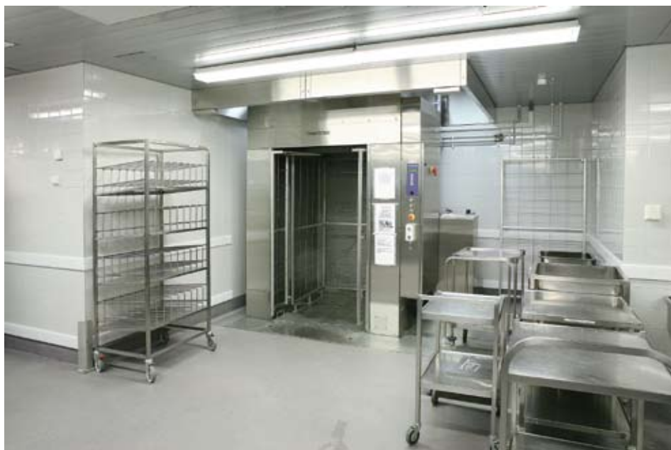
Vaununpesukone on upotettu samaan tasoon lattiapinnan kanssa.
