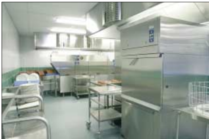
Astianpesua ohjaa ympäristöystävällinen Metos ICS -koritunneliastianpesukone ja valmistus- ja kuljetusastiat pestään Metos GR-80 -raepesukoneessa.
