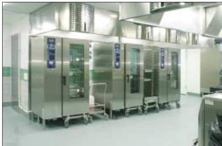
Itsensä pesevät uunit vapauttavat keittiöhenkilökunnan muihin tehtäviin, kuten myöskään kypsennyksen aikana uuneja ei tarvitse vahtia.
