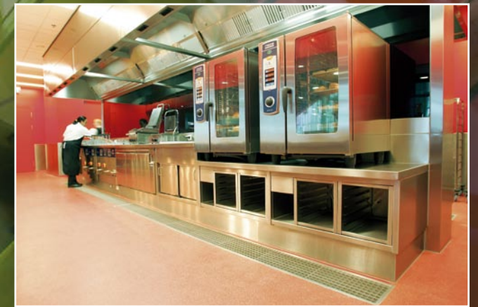
Yhtenäiset teräspinnat ja umpisokkelit nopeuttavat siivoamista ja parantavat hygieniaa.
